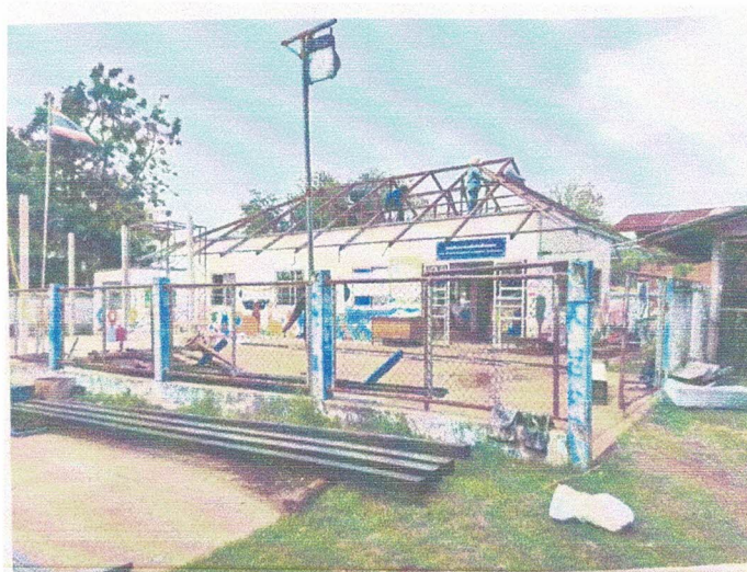
โครงการปรับปรุงต่อเติมอาคารศูนย์พัฒนาเด็กเล็กบ้านโนนหอม ม.๑๑ โดยเปลี่ยนหลังคาและฝ้าเพดาน หน่วยงานรับผิดชอบหลัก : สำนักปลัดอบต.
