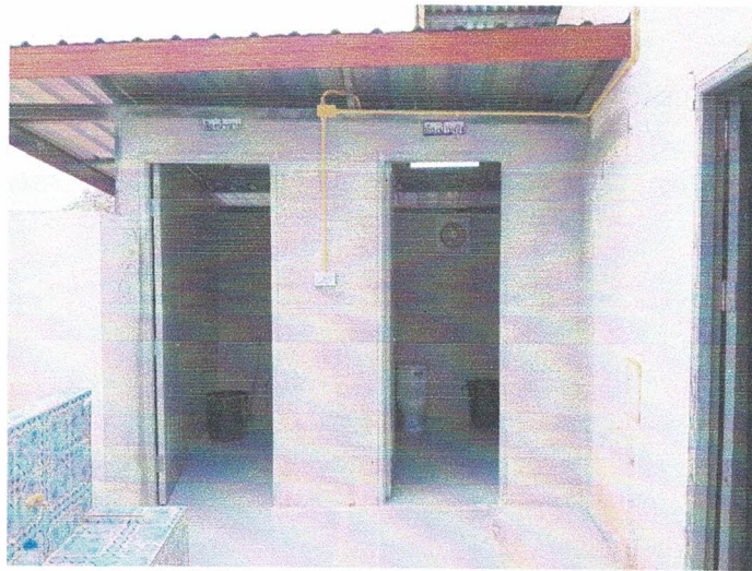
โครงการปรับปรุงต่อเติมอาคารศูนย์พัฒนาเด็กเล็กบ้านหนองหอย ม.๔ โดยปรับปรุงห้องน้ำ
