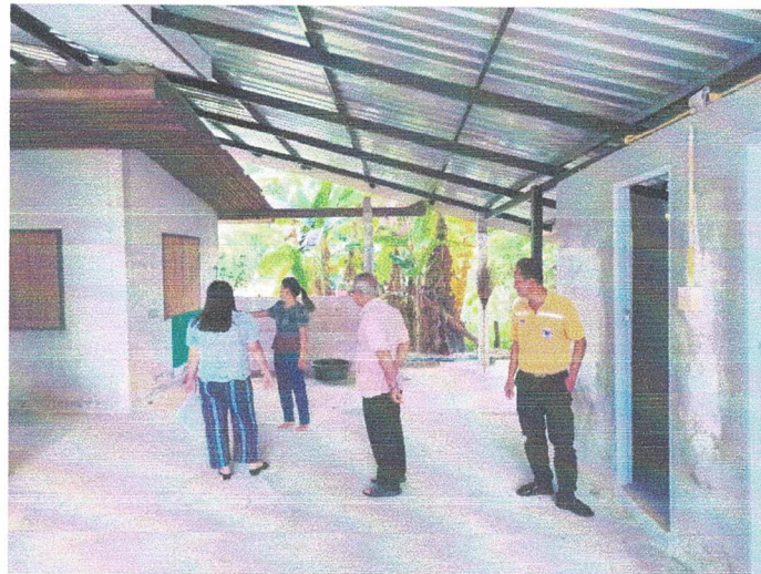
โครงการปรับปรุงต่อเติมอาคารศูนย์พัฒนาเด็กเล็กบ้านนาล้อม ม.๙ โดยปรับปรุงห้องครัวและห้องน้ำ
